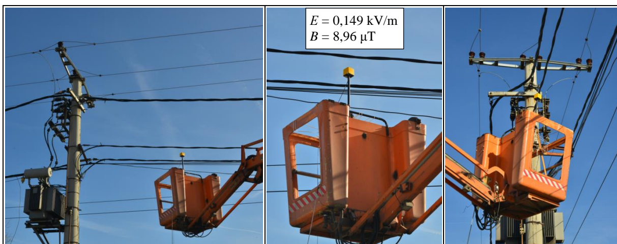
СЛИКА 9 – ПОЗИЦИЈА МЕРНОГ МЕСТА (ИСПОД БЛИЖЕГ 0,4 KV СКС-А) И РЕЗУЛТАТИ МЕРЕЊА ( H = 6 \text{ M} ; H_K = 4,3 \text{ M} ; H_S = 1,7 \text{ M} )
